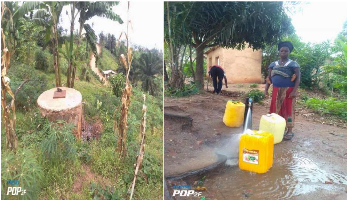
*Photos du réservoir aménagé à la place de la source et une borne fontaine installée sur la sous colline Nyamuzi.*
