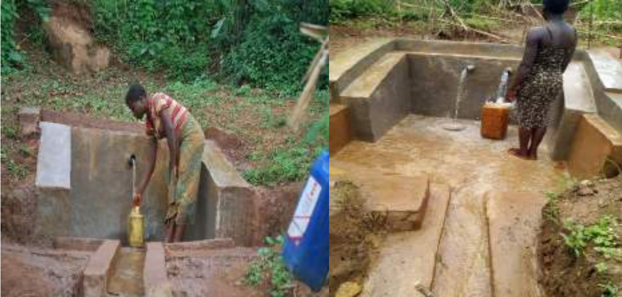
Source d'eau aménagée en commune Burambi
