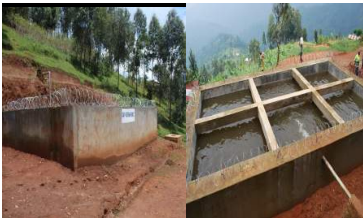
Bassins de retenue de l'eau du captage de la rivière Menshi
