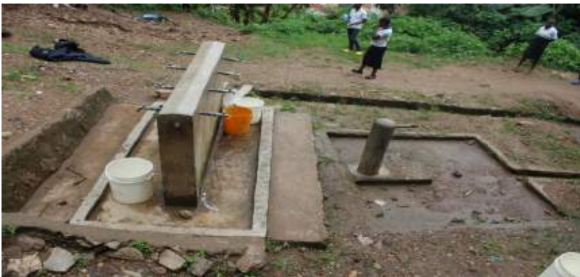
Ouvrage de lavage des mains installé à l'ECOFO Nyamaboko
