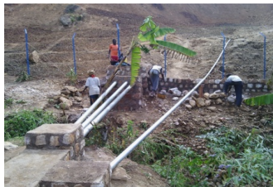
Pose de tuyaux dans la tranchée Borne fontaine mise en et transport d'eau place AEP Kibuye
