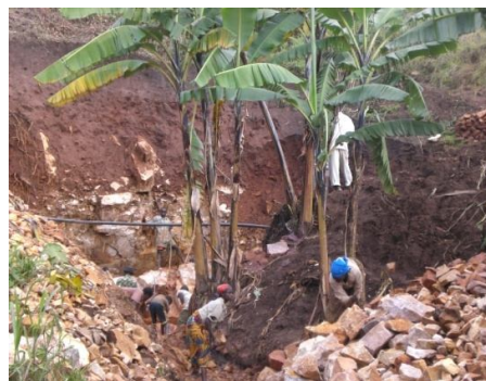
Terrassement pour les travaux de captage de la source Nyagatare
