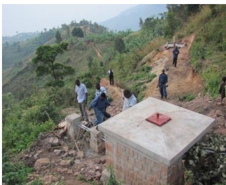
Chambre de départ du réseau
