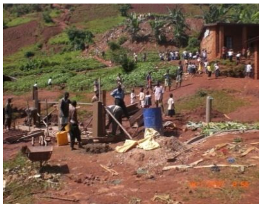
Photo 2 : Construction des bornes fontaines par la population
