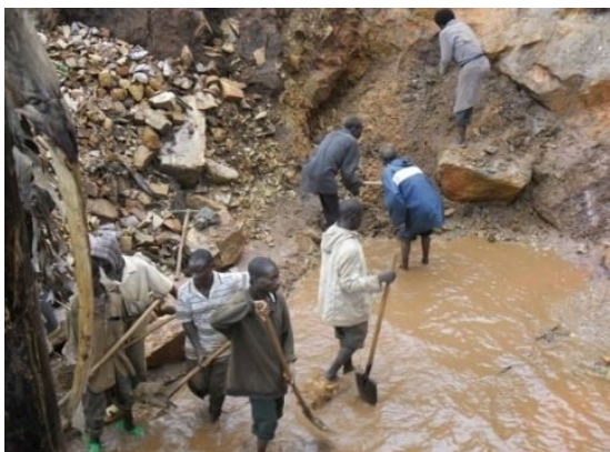
Photo 1 : Travaux de captage de source par la population à l'œuvre pour l'exécution des travaux.
